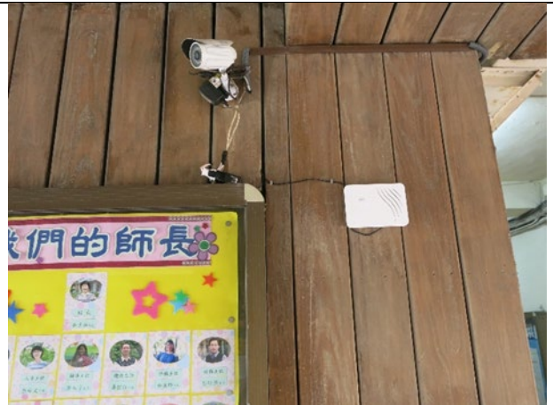
說明：偵測器安裝
