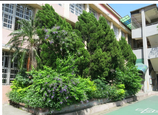
施工前-植栽過高不易修剪
