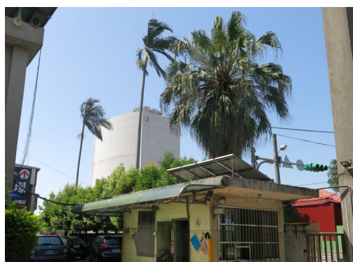
施工前-植栽過高不易修剪
