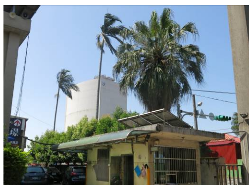
施工前-植栽過高不易修剪
