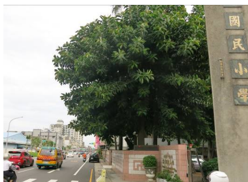
施工前-植栽過高不易修剪
